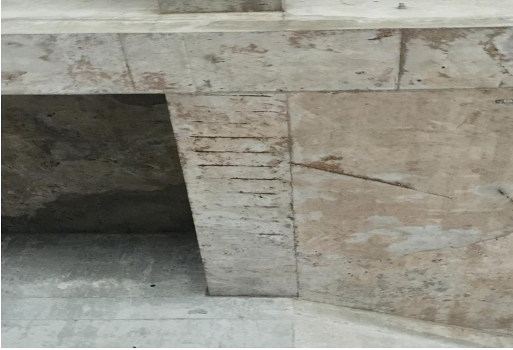
2. 1#楼 5 层个别构造柱砼浇灌到上部与梁底间不密实。
