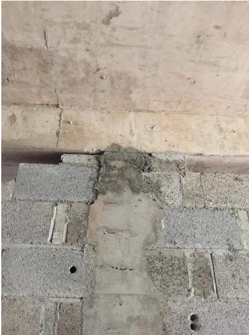
2. 1#楼 5 层个别构造柱砼浇灌到上部与梁底间不密实。
